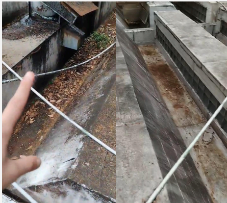
Dia de arrumação do telhado do prédio. A esquerda o antes e a direita o depois.
